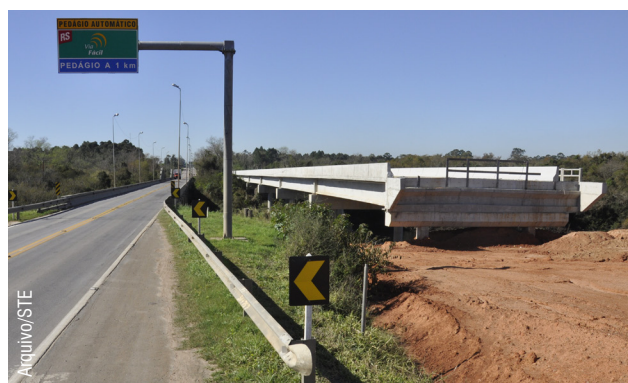
Obras na ponte sobre o Arroio Pelotas estão concluídas.
